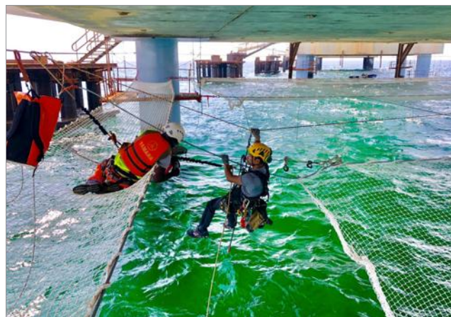
Les équipes d'Altius ont travaillé sur un projet délicat : permettre à une entreprise de procéder à des travaux de sablage et de peinture sur une plateforme d'exploitation de minerais, au large du Togo. Photo Altius
